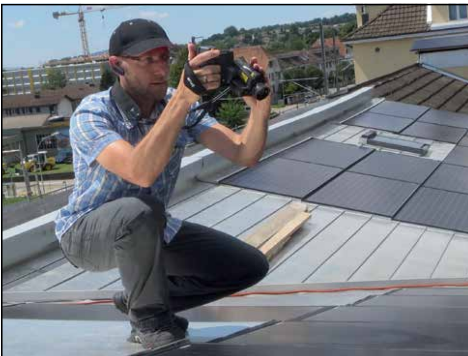
Mit Hilfe eines Bluetooth-fähigen Headsets können gesprochene Kommentare einem Bild hinzugefügt werden. Ich kann dann einfach ein Bild kommentieren, zum Beispiel 'dritte Reihe, zweites Modul von links'.
