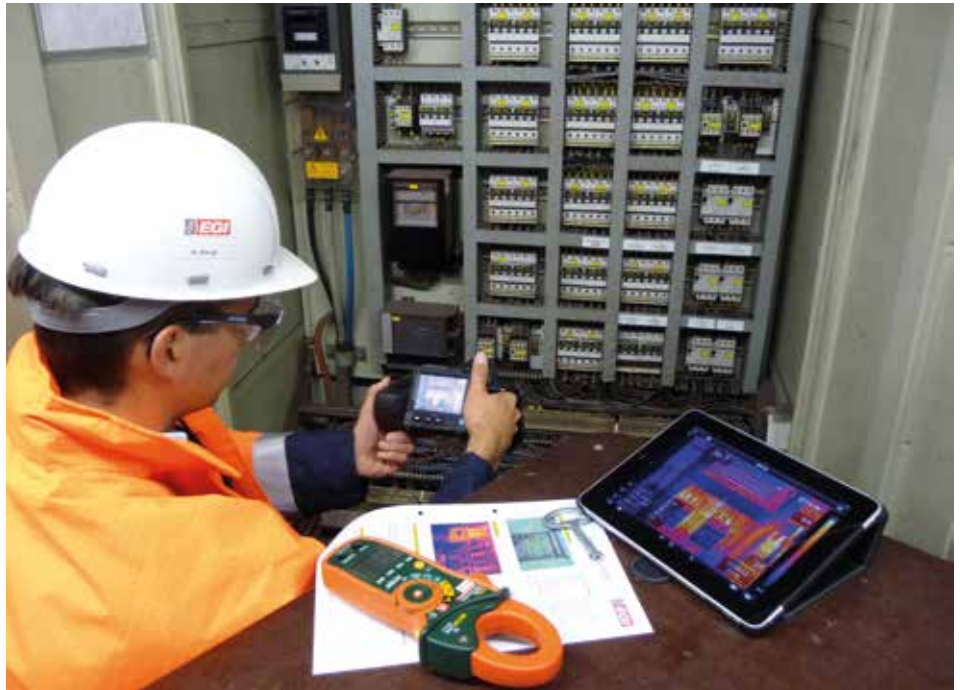
Michael Weigt beim Thermografieren: Die Daten der Extech-Stromzange werden per Bluetooth in das Infrarotbild integriert. Die FLIR T440 überträgt die Infrarotaufnahmen per WLAN an einen Tablet-PC.
