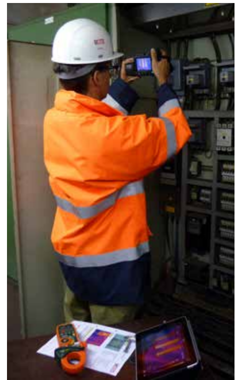
Beim Thermografieren in engen Räumen nutzt Michael Weigt ein zusätzliches 45°-Weitwinkel-Wechselobjektiv an seiner FLIR T440.
